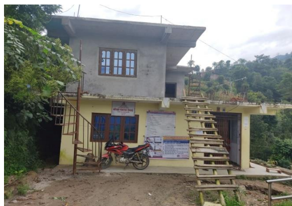
मेनपा २ स्थित निर्माणाधीन स्वास्थ्य इकाई भवन
