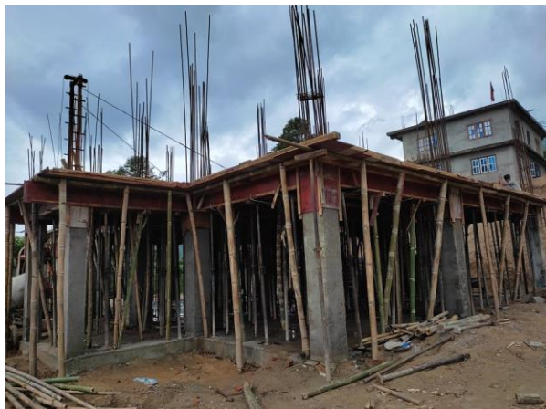
वडा नं. ८ को निर्माणाधीन वडा कार्यालय भवन
