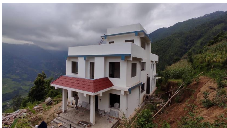
वडा नं. ५ को निर्माणाधिन वडा कार्यालय भवन
