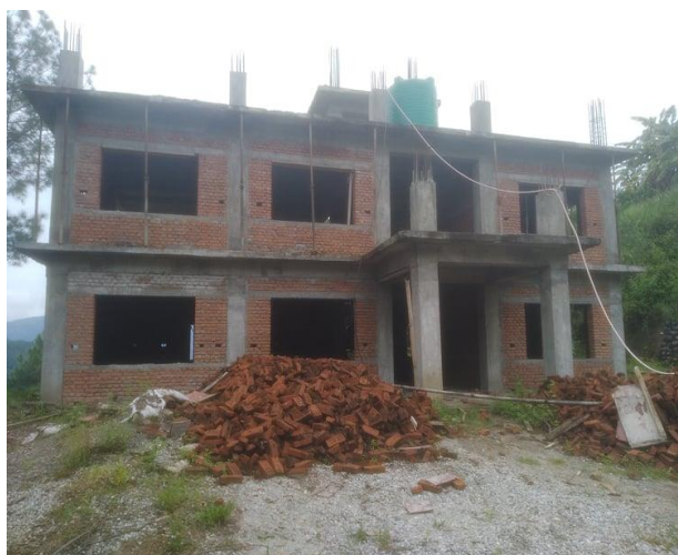
वडा नं. १० को निर्माणाधीन वडा कार्यालय भवन
