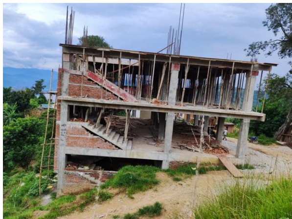
वडा नं. १३ स्थित निर्माणाधीन वडा कार्यालय भवन
