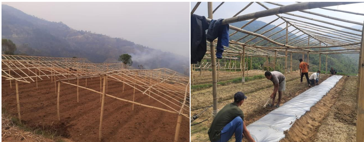
मेनपा १२ स्थित ढकालथोक र गिराच्चौर मा निर्माण गरिएको प्लाष्टिक घर र मल्लिङ
