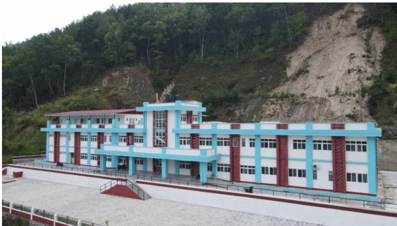
मेलम्ची नगरपालिका वडा नं. ११ स्थित नगर अस्पताल भवन
